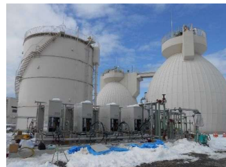
消化タンク脇に設置された発電施設
