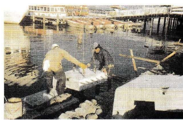
写真4-23 波返し護岸工底部ブロック設置
