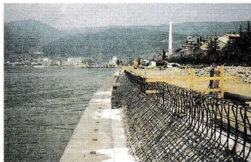
写真4-24 波返し護岸工鉄筋施工組立
