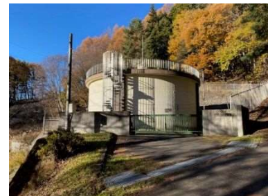
すわし はいすいち 諏訪市の配水池
