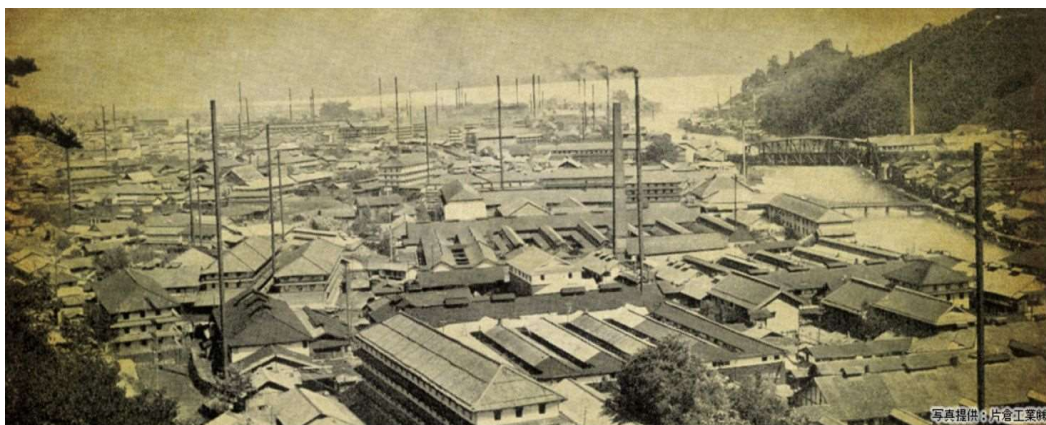
天竜川沿いに建てられた製糸工場群
