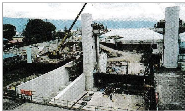
工事中の写真 左側に魚道が見える
