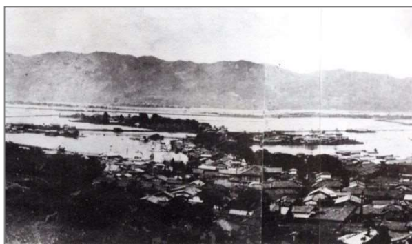
明治44年8月に発生した高島城付近浸水状況
