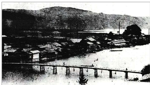
二代目釜口橋 幅9尺（2.7m）
