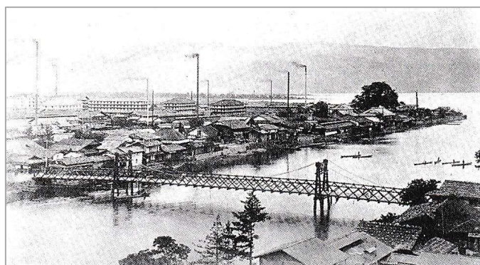
3代目の釜口橋 幅2間（3.6m）
