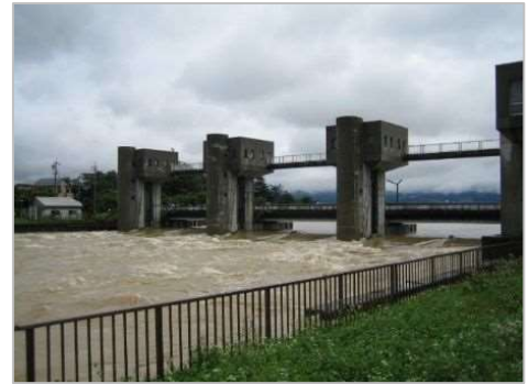
当時の釜口水門付近の様子
