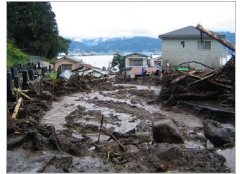
小田井沢下流部被害状況
