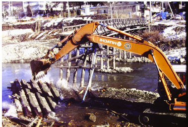
旧橋（木橋）の取り壊しの様子
