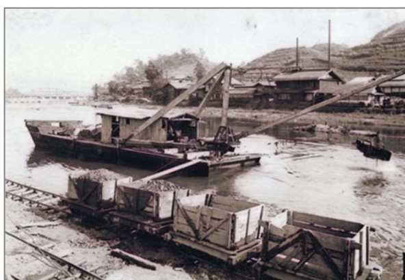
橋原地区の河床掘削工事
