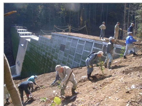
整備されたえん堤法面に植栽
