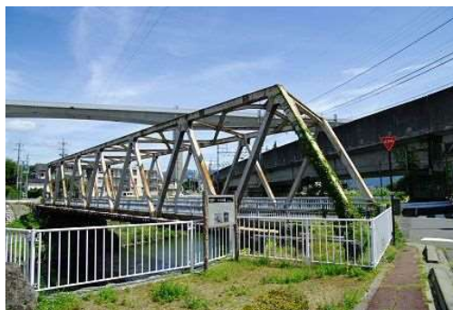
現在の橋原橋 型式；下路式単純ワーレントラス 橋長；56.7m 幅員；6.0m 上流に人道橋 幅員1.5m 竣工；昭和58年(1983年) 左岸下流橋詰めにピツタラ橋の模型
