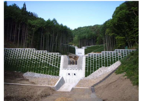
小田井沢に整備された砂防えん堤
