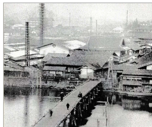
幅がかなり広い 上流に杭が見える
