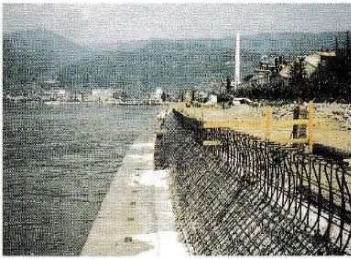
写真4-24 波返し護岸工軟筋施工組立
