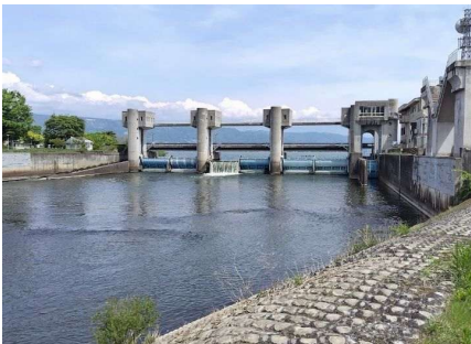
釜口水門を下流から 左岸(右側)は舟通し 天竜川沿いの魚舟が諏訪湖を通行するため パナ マ運河方式を採用。2門のゲート間に舟を入れて 水位を合わせて通行させることができます。
