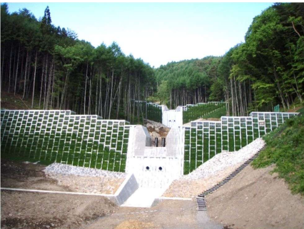
平成18年7月豪雨災害を受け流入河川に砂防えん堤が整備され土砂などの流入負荷が減少
