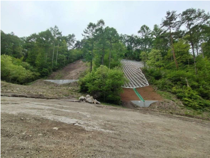
小田井沢上流令和3年8月豪雨災害箇所にて整備された治山施設山腹工及び土留め工
