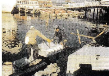
写真4-23 波返し護岸工底部ブロック設置
