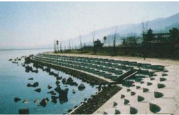
階段式護岸工
