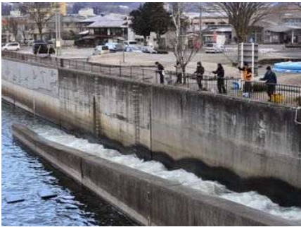
釜口水門右岸に設置された魚道 諏訪湖と天竜川の水位差約3.5m、流量は2～ 4 m 3 流速は2m以下に
